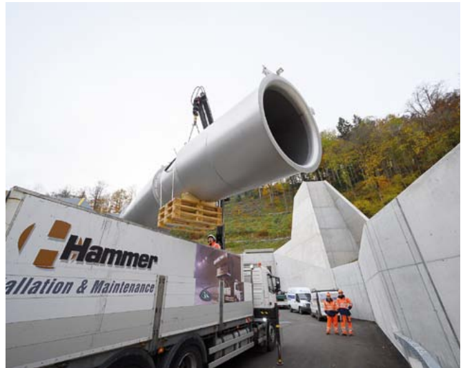
Mitte November 2019 wurden die Strahlventilatoren angeliefert und ...
