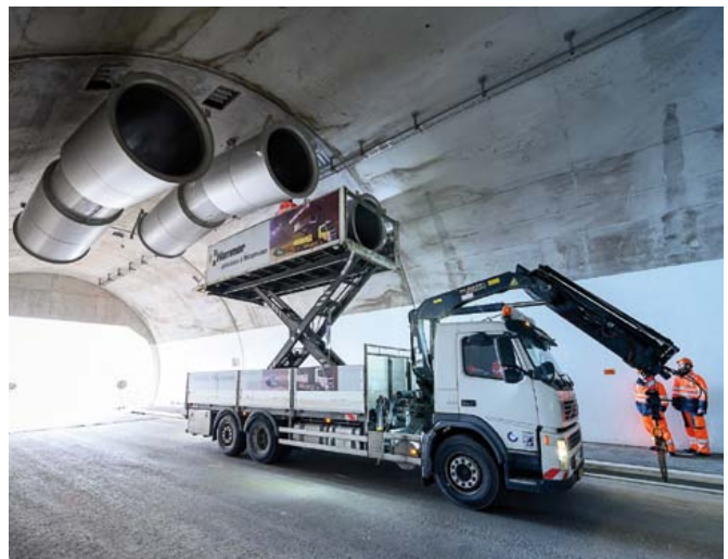
... gleichentags erfolgte die Montage der 1,7 Tonnen schweren Ventilatoren.
