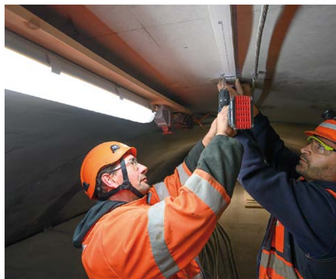
Montage der Beleuchtungsabgänge im Abluftkanal mittels Spezialadapter auf Flachbandkabel.
