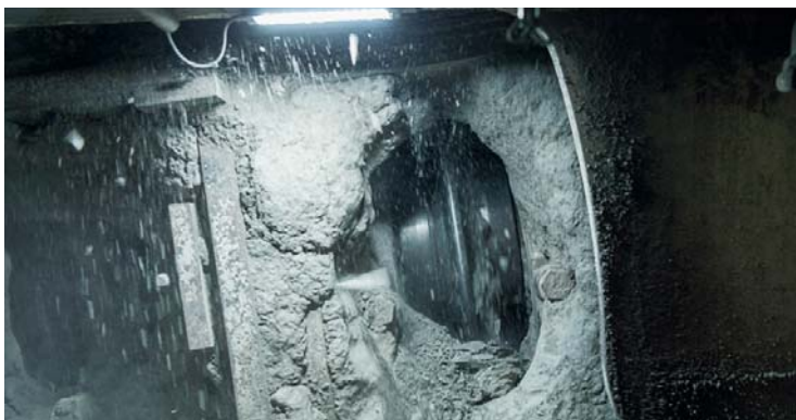
Sektor A: 79 Rollen am Bohrkopf der TBM schneiden sich in den Fels.
