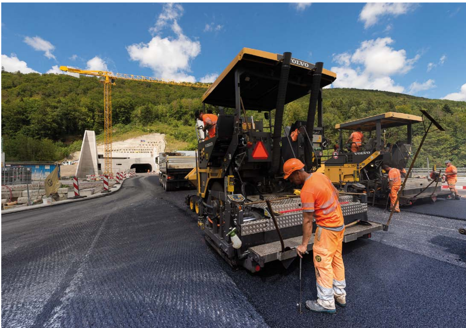
Alleine mit Belagsarbeiten werden annähernd 42 000 Tonnen Material «verbaut».
